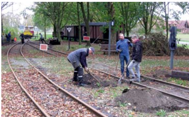
Die Studierenden-Rotte beim Gleisbaueinsatz in Heiligenberg: Schwellenwechsel und Gleisstopfen standen auf dem Lehrplan.
