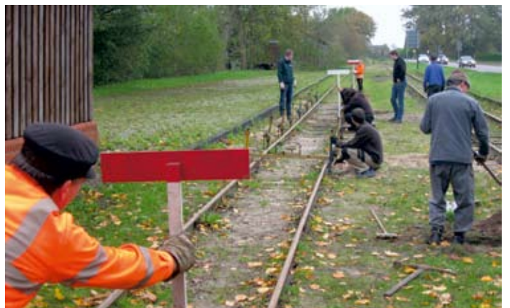
Mit einfachen optischen Hilfsmitteln und Winden wird das Ladegleis nivelliert. 29. Oktober, 2 Fotos: DM
