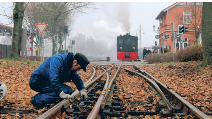
An der Bahnhofseinfahrt aus Richtung Syke wartete Jannik Westermann die Weichen. Viel Laub musste entfernt werden und anschließend lief alles wieder wie geschmiert.
