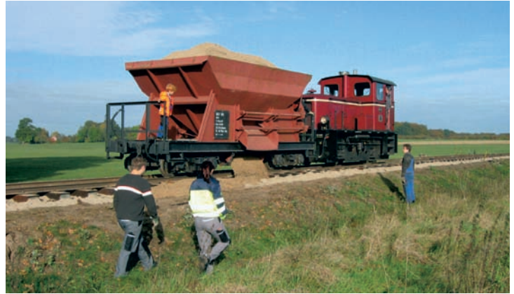
Anschließend konnte mittels Diesellok V3 und Schotterwagen 162 noch eine Lage Kies ausgebracht werden. Heiligenberg, 29. Oktober 2016, zwei Fotos: Dennis Mellerowitz
