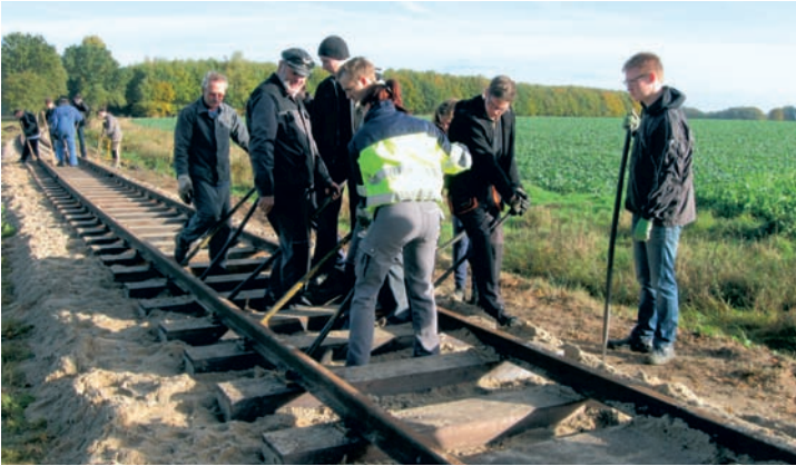
Eine Gruppe Studierender half, das letzte Stück der erneuerten Heiligenberger Kurve fertigzustellen: Nach dem Hochstopfen wird das Gleis mittels Brechstangen in die richtige Lage gebracht.
