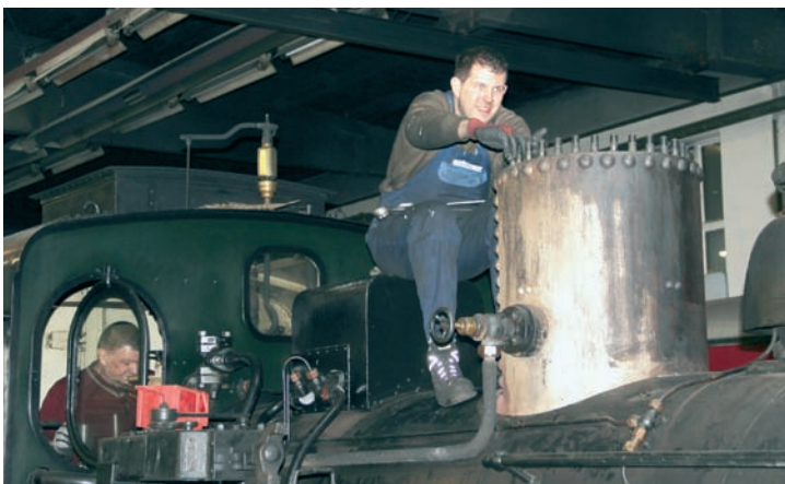
Stephan und Wolfgang Moll bei den schwierigen Demontearbeiten an Kessel und Armaturen von Lok SPREEWALD.
