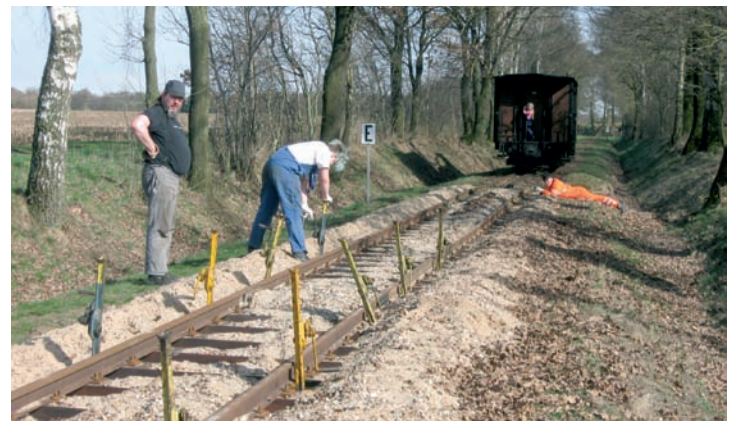
Das Peilen der Höhenlage und Ausrichten der Winden erfordert bisweilen „Bauchlage“.
