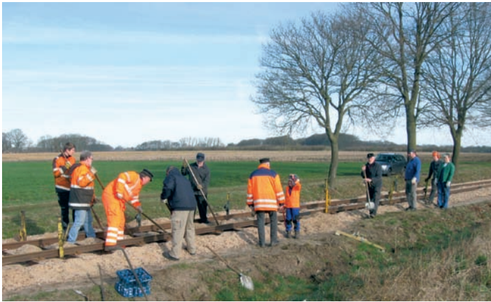
Das Gleis sind bereits fertig montiert und in der Lage ausgerichtet, müssen aber noch gestopft werden.
