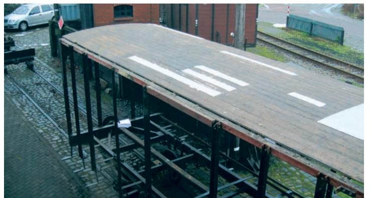
Das Dach vom Pw 51 ist noch recht gut erhalten, nur einzelne Bretter mussten ausgetauscht werden. Bruchhausen-Vilsen, 15. Dezember 2012
