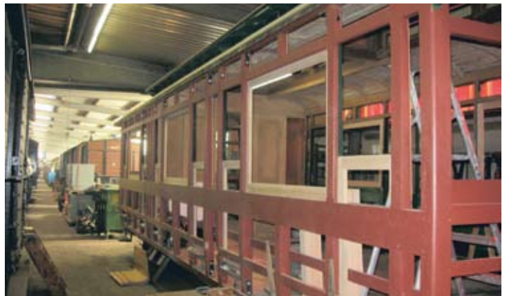
Am Weyer-Personenwagen Nr. 16 werden die neuen Fensterrahmen eingepasst.
