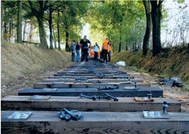
Studierende der Hochschule Bremen als Unterstützung der DEV-Rotte kurz hinter dem Einschnitt hinter dem Vilser Holz: Schwellen, Unterlagsplatten und Schwellenschrauben sind schnell ausgelegt.
