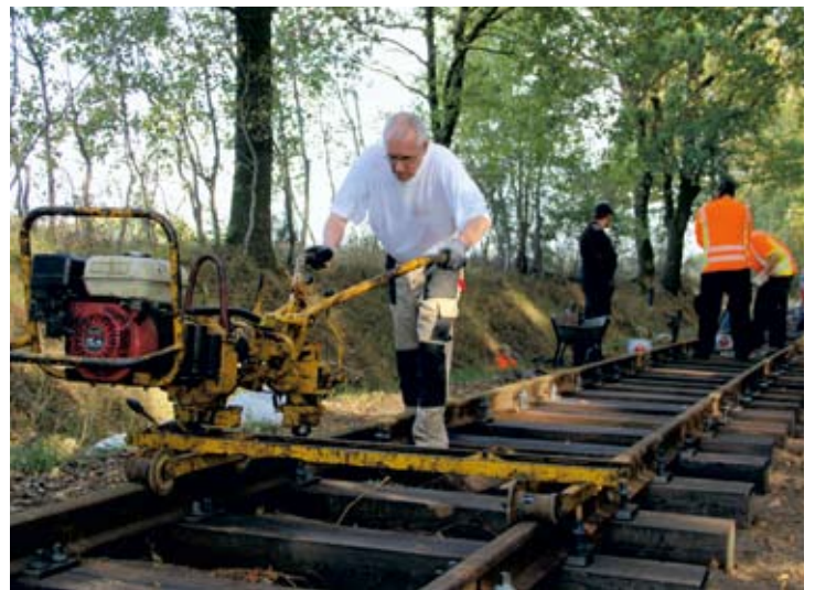
Die Arbeiten zur Gleiserneuerung sind in vollem Gange: Hier Christian Uhle an der Schraubmaschine und weitere Aktive im Hintergrund.
