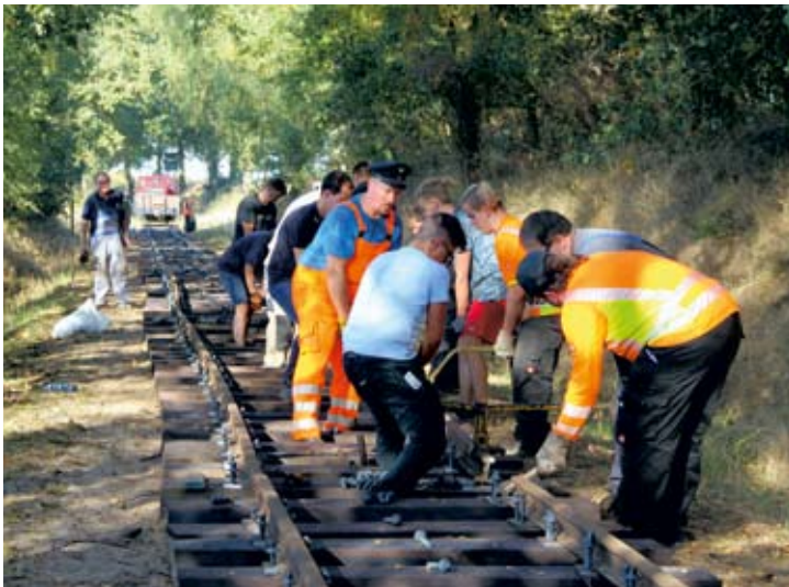
Dank der Verstärkung der DEV-Rotte durch die Studierenden der Hochschule Bremen und einigen weiteren Freiwilligen konnten die etwa 15 Meter langen Schienen gut von Hand auf die Schwellen aufgesetzt werden.
