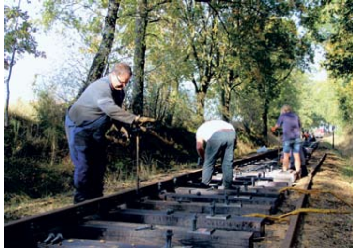
Gleismontage wie vor 100 Jahren: DME-Redaktionsleiter und langjähriger Rottenaktiver Dennis Mellerowitz beim Eindrehen der ersten Schwellenschrauben von Hand.
