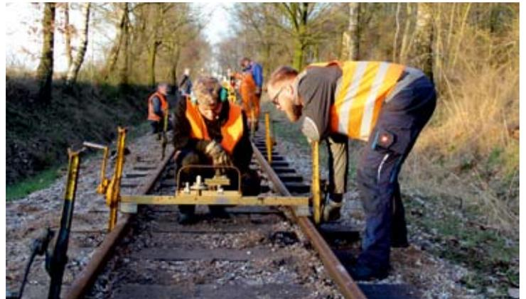
Sind beide Schienenstränge auf gleicher Höhe? Lars Böcker und Alexander Angerhausen beim Nivellieren des Gleisrosts.
