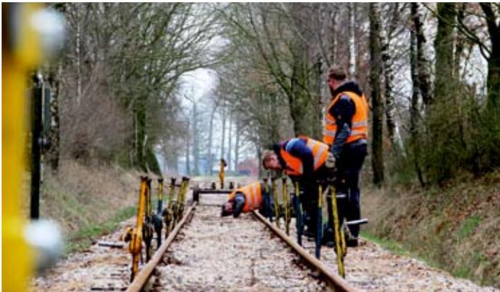
Bevor die Stopfmaschine arbeiten kann, muss das Gleis mit Winden ausgerichtet werden.
