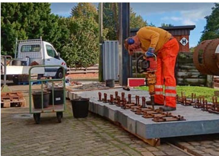
Nach der „Schwarzmalerei“ wurden die Unterlagsplatten von Jens Böcker auf die Schwellen geschraubt. Durch die Vormontage dauert die Montage des Gleises an der Baustelle nicht so lange. 14.10.2023, Foto: Klaus Eggemann
