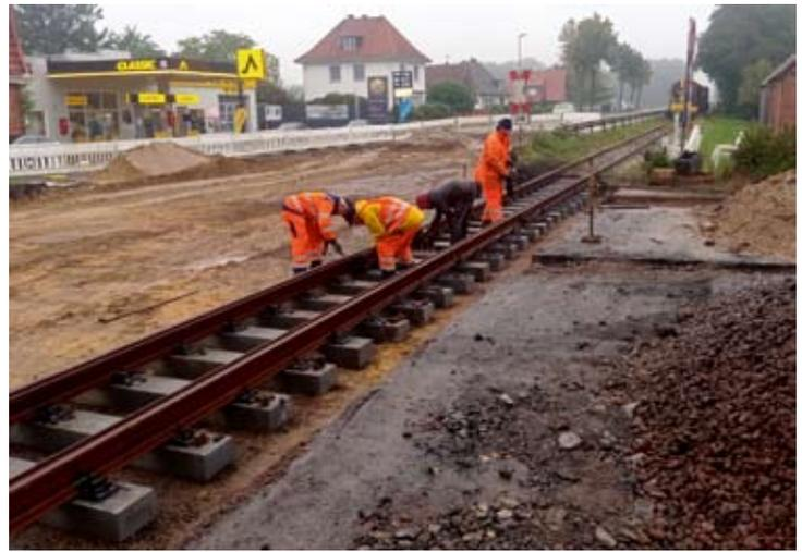
Auch bei Regen wurde unermüdlich weitergearbeitet an der Montage des Gleises. Gut konserviert wurde das Kleinisen nach und nach verschraubt, die DEV-Rotte stand unter Zeitdruck. 19.10.2023, zwei Fotos: Robert Angerhausen
