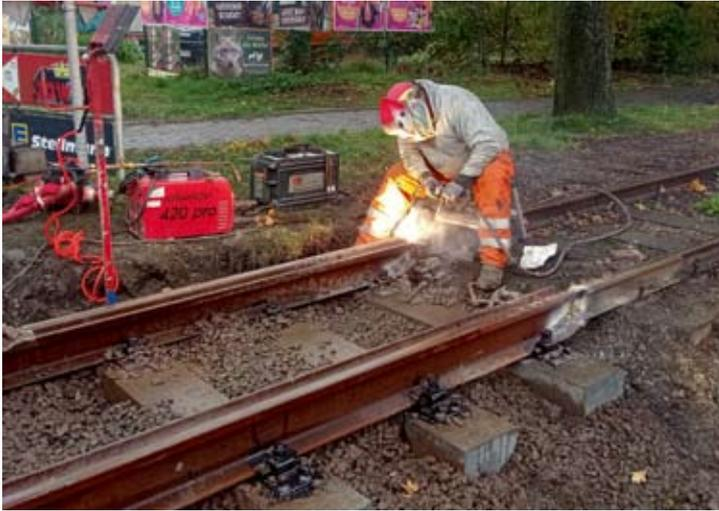
Am Freitagmorgen wurden die Anschlüsse der Rillenschienen an die Vignolschienen von einer Fachfirma verschweißt. Danach ging es weiter mit Verfüllen des Gleises und Stopfen. 20.10.2023
