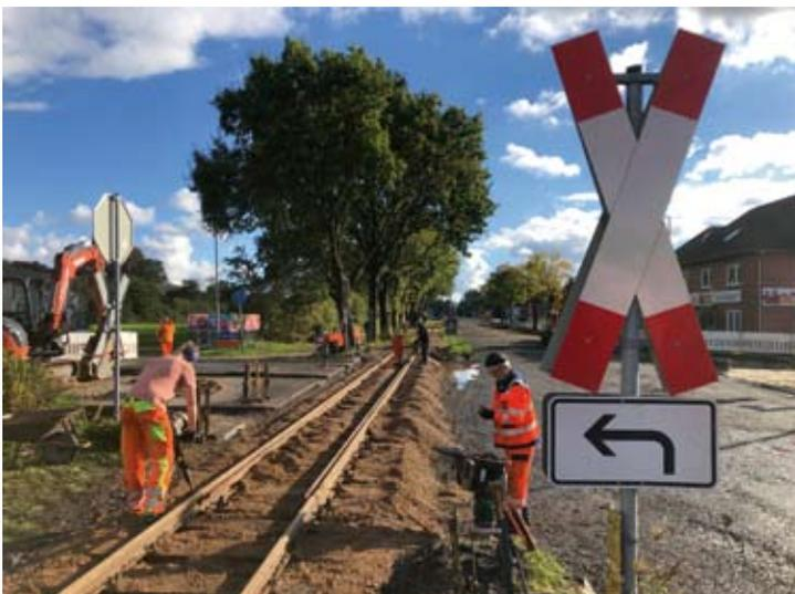
Gegen 15 Uhr fanden die letzten Arbeiten statt, das Gleis lag schon gut. Max Hunold stopfte an den Schienenstößen noch mit dem Stopfhammer, die anderen räumten auf bzw. kontrollierten die Gleislage. 21.10.2023, Foto: Konrad Mans
