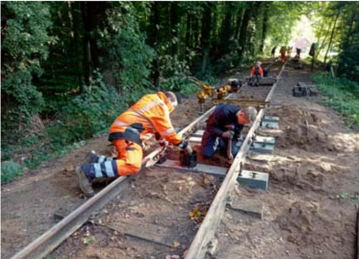
Nachdem die neuen Schwellen unter den Schienen eingebaut waren, wurden sie am Ende des Bahnsteigs Vilsen Ort bereits mit konservierten Unterlagsplatten und Schwellenschrauben versehen. 17.10.2023
