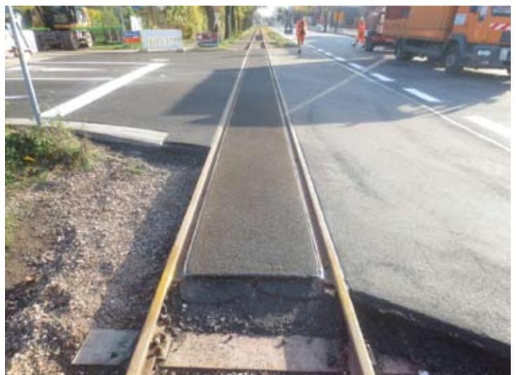
Nach Beendigung der Gleisbauarbeiten wurde der Bahnübergangsbelag fertiggestellt von der Straßenbaufirma und zum Abschluss die Fahrbahnmarkierungen aufgebracht. Das sieht schon gut aus. 08.11.2023, Foto: Guido Tschigor
