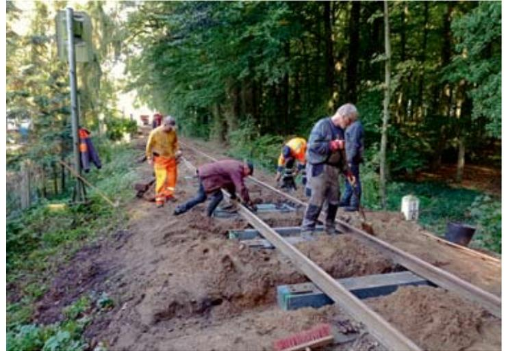
Am Folgetag sind die Arbeiten voll im Gange und die ersten neuen Schwellen bereits unter den Schienen. Der Einzelschwellenwechsel ist eine mühsame Tätigkeit, aber unerlässlich, wenn nicht der ganze Gleisabschnitt saniert werden soll. 17.10.2023
