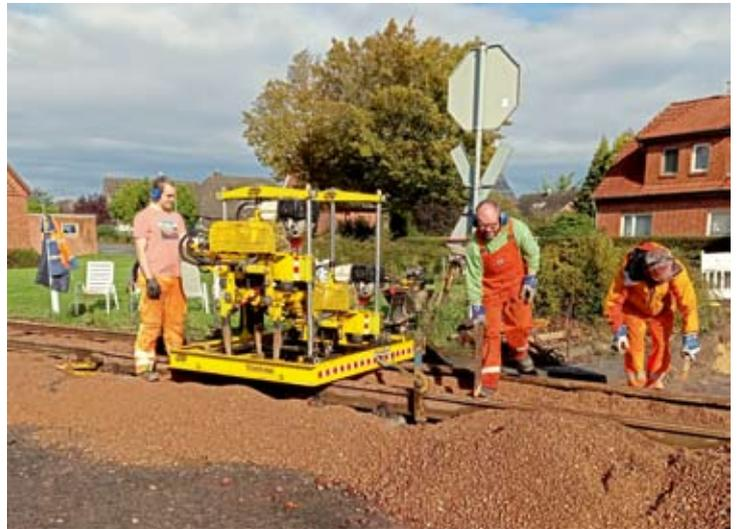
Gut gestärkt wurden die Arbeiten nach dem Mittag fortgesetzt und auch die Sonne ließ sich wieder blicken. Das Gleis wurde mit Winden auf Höhe gebracht und dann mit der Stopfmaschine gestopft. 21.10.2023, Foto: Robert Angerhausen
