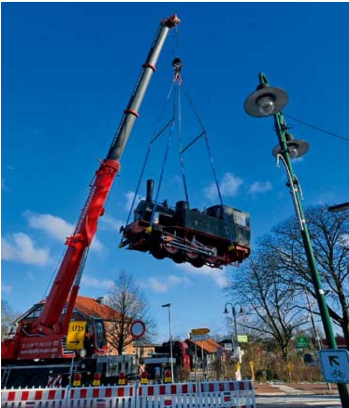
Bei strahlendem Sonnenschein wurde die Lok BRUCHHAUSEN vom Sockel gehoben und auf Reisen geschickt. Sie wird in Bremen gesandstrahlt und beschichtet, wie zuvor JAN REINERS aus Findorff. 08.01.2024, Foto: Slg. Uwe Franz
