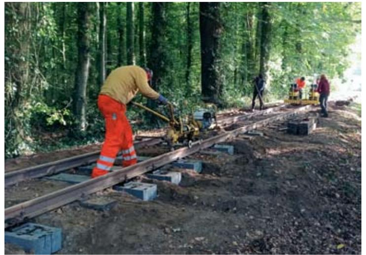
Am Nachmittag schraubte Jens Böcker fleißig mit der Schraubmaschine und im Hintergrund wurde bereits gestopft. Die Zusammenarbeit in der Mehrgenerationen-Gleisbaurotte war wieder sehr produktiv!
