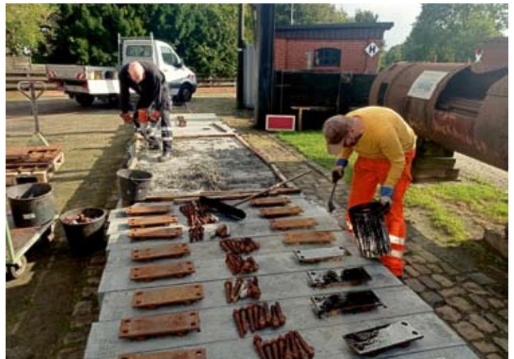
Im Freien und bei Sonnenschein wurden neue Kunststoffschwellen von Klaus Eggemann gebohrt, sowie Unterlagsplatten und Schrauben vor der Montage mit einem Bitumenlack von Jens Böcker konserviert. Zwei Fotos: Robert Angerhausen
