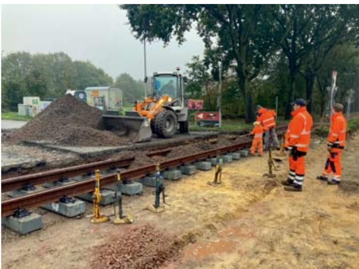
Gegen 17:30 Uhr dämmerte es bereits, als der Schotter bzw. Splitt mit dem Radlader eingebracht wurde und der Gleisrost verfüllt. Die Feinverteilung des Materials erfolgt von Hand. 19.10.2023, Foto: Jens Böcker
