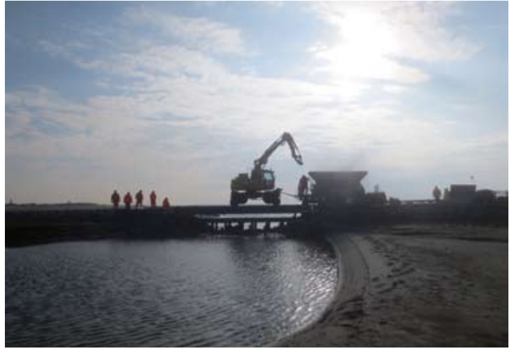
Für die Bauarbeiten wurde der DEV von der Baufirma um Ausleihe des Schotterwagens 163 gebeten und so reiste dieser im Frühjahr auf die Insel. Hier ist der Wagen im Einsatz mit einem Zweibegebagger zu sehen. Gut erkennbar auch der Höhenunterschied zwischen der alten und neuen Brücke. 06.03.2024
