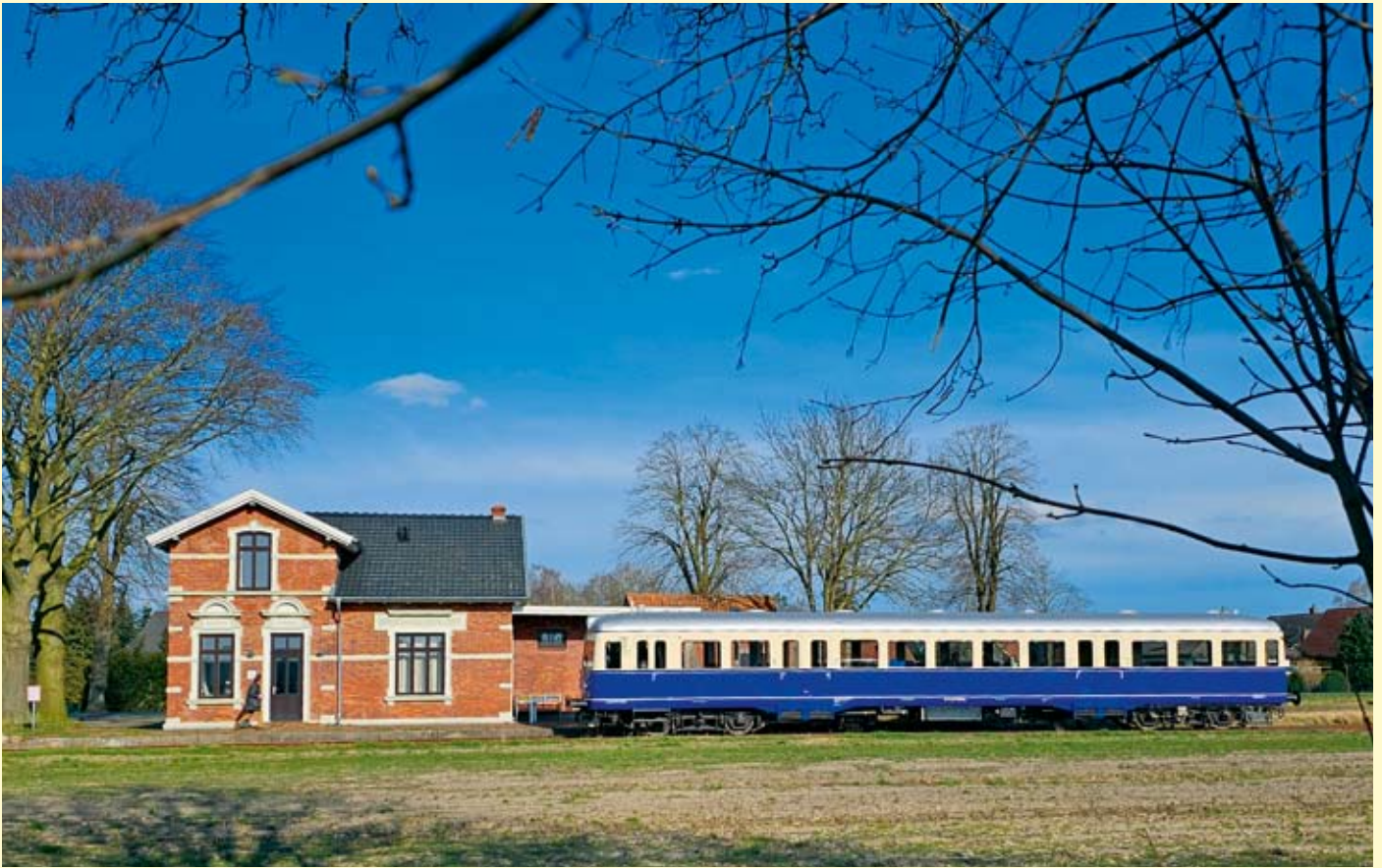
Nach Abschluss der HU ist der T 2 wieder im Einsatz. Bei der Sonderfahrt des Förderkreises Schienenfahrzeugtechnik Hannover e.V. zu dessen Hauptversammlung in Bruchhausen-Vilsen wurde am Bf Bruchhausen Ost (der „Villa Gleisbett“) ein Fotohalt eingelegt bei strahlendem Sonnenschein. 02.03.2024, Foto: RM
