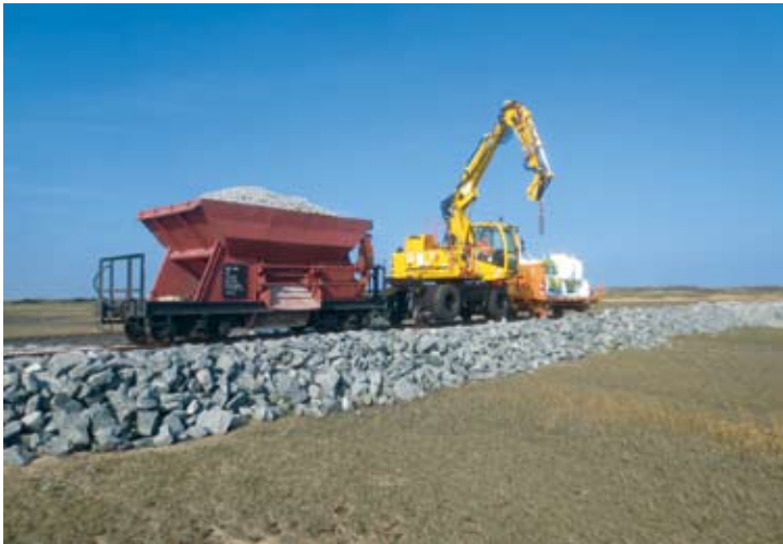
Am Nachmittag desselben Tages war das Wasser abgelaufen und Schotterwagen 163 wieder mit dem Zweibegebagger unterwegs. Bei strahlendem Sonnenschein kann man die Steinschüttung der erhöhten Trasse erkennen. Das Gleis muss noch eingeschottert werden. 06.03.2024, 3 Fotos: Guido Tschigor
