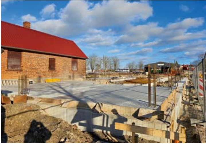
Keine vierzehn Tage nach der Grundsteinlegung des Lokschuppens in Bruchhausen-Vilsen ist schon die Fußbodenplatte des Werkstattbereiches betoniert und die ersten Bewehrungsseisen für die Pfeiler sind zu sehen. Das ehemalige HSA-Rottengebäude, das erhalten bleibt, ist noch gut zu sehen von der Straßenseite 17.02.2024
