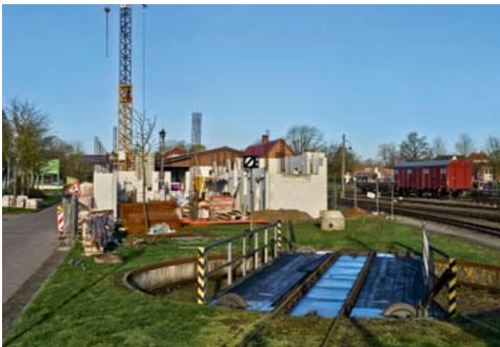
Zwischen Gleisbau- und Ostermeeting war am frühen Morgen Zeit für einen Blick auf die Baustelle. Hinter der Drehscheibe ist nun der Baukörper des Lokschuppens durch die Mauern gut zu erkennen und vom Rottengebäude ist nur noch die Spitze des Daches zu sehen. Der Neubau nach historischem Vorbild wächst stetig. 23.03.2024
