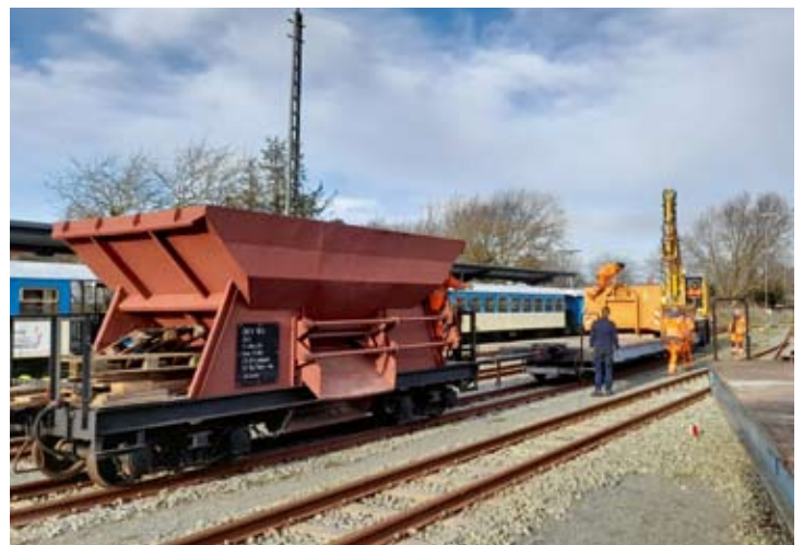
Ende März war der Arbeitseinsatz von DEV-Wagen 163 auf der Insel beendet und der Wagen stand im Bf Wangerooge mit einem Arbeitszug bereit zur Abfahrt Richtung Anleger. Im Hintergrund zu sehen ist der Personenzug für die planmäßigen Fahrten zur Fähre nach Harlesiel. 26.03.2024
