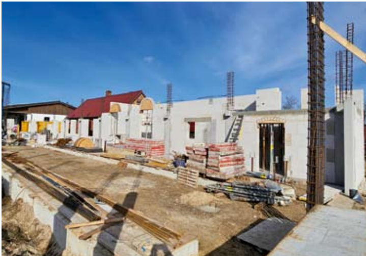
Nach weiteren zwei Wochen sind die Mauern des Lokschuppens zur Gleisseite weiter gewachsen und erste Tür- und Fensteröffnungen sind in Arbeit. Die Pfeiler sind abschnittsweise betoniert, einschließlich der Auflager für die Dachbalken und vom ehemaligen Rottenschuppen ist eigentlich nur noch das Dach sichtbar. 17.03.2024
