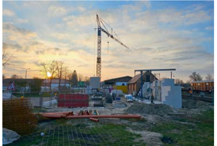
Am ersten Sonntag im März sind in der Abendsonne die Fußbodenplatte und die ersten Mauern des Werkstattanbaues zu sehen. Mittlerweile ist ein Turmdrehkran aufgebaut, der die Materialbewegungen bei Anlieferung und auf der Baustelle erheblich vereinfacht. Aus Blickrichtung Drehscheibe „verschwindet“ der alte Rottenschuppen so langsam. 03.03.2024
