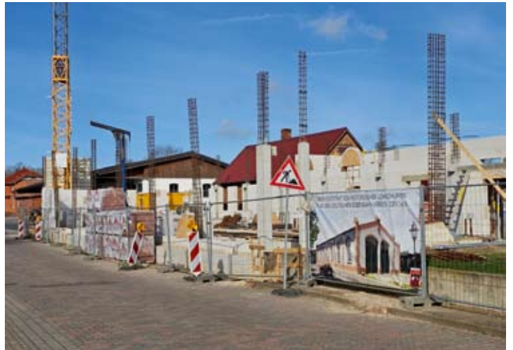
Auch auf der Straßenseite „wächst“ der Lokschuppen. Durch die Bewehrungskörbe der Pfeiler ist die Höhe der Mauern nun zu erahnen und dank des Transparents am Bauzaun ist die Gestaltung des Bauwerks für alle Besucher zu sehen. Die ersten Paletten mit roten Klinkern sind auf der Baustelle angekommen. 17.03.2024
