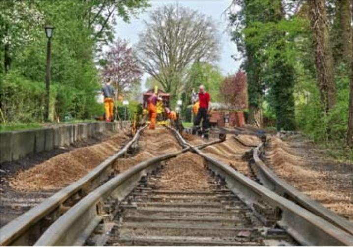
Nach der Erneuerung der Bahnsteigkante und dem Schwellenwechsel im März 2024 standen Mitte April die Stopfarbeiten im Bf Vilsen Ort an, um das Gleis der Museums-Eisenbahn befahrbar für die neue Saison zu machen. Gut erkennbar ist, dass das Gleis ordentlich angehoben und viel Kies unter das Gleisrost gebracht werden musste.
