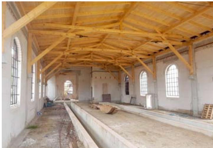
Mit der Balkenkonstruktion nach historischem Vorbild, dem geschlossenen Dach und den bereits montierten Fenstern wirkt der Lokschuppen nun wie eine „Kleinbahn-Kathedrale“ für die Dampfloks. Es fehlen noch der Putz an den Wänden, die Verklinkerung des Bodens und der Gruben sowie die Gleise. 27.06.2024
