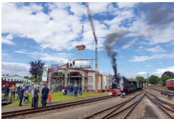
Nach Anlieferung der Dachhaube mit dem Sonderzug wurde diese mit dem Turmdrehkran abgeladen, angehoben und auf der Dachkonstruktion abgesetzt. Anschließend dann endgültig montiert für die Be- bzw. Entlüftung des Lokschuppens wie beim alten Schuppen in Hoya. 15.06.2024
