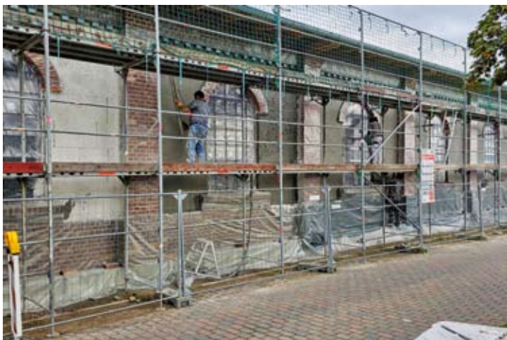
Auf der DEV-Lokschuppenbaustelle gingen die Arbeiten den ganzen Sommer kontinuierlich voran. Anfang August waren die Verputzarbeiten in vollem Gange, das trockene Wetter wollte genutzt werden. 08.08.2024
