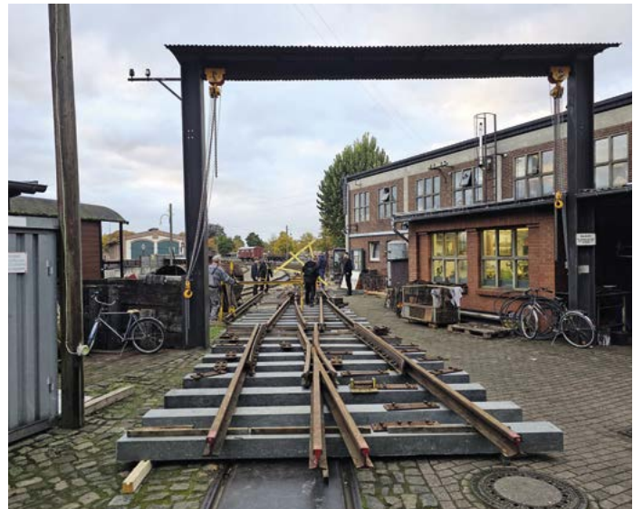
Weiche 3 im Bf Bruchhausen-Vilsen wird mit Kunststoffschwellen neu aufgebaut und für den Einbau vorbereitet.
