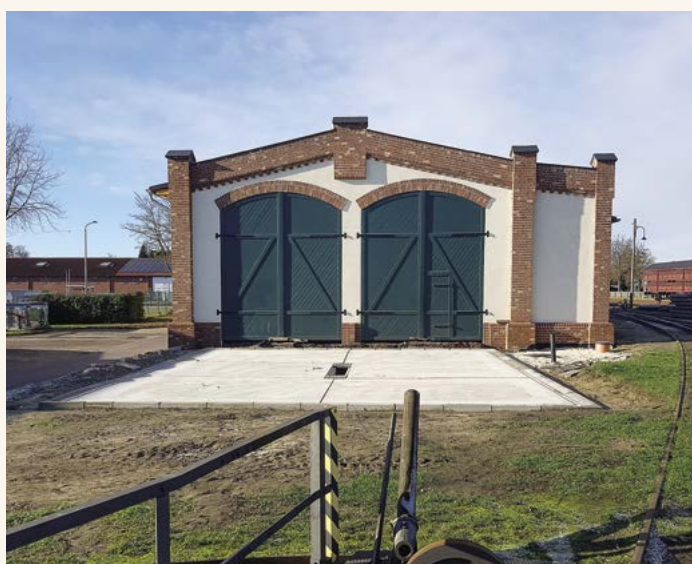
Vor dem Lokschuppen ist inzwischen auch die Waschplatte mitsamt der neuen Abscheideranlage fertiggestellt.
