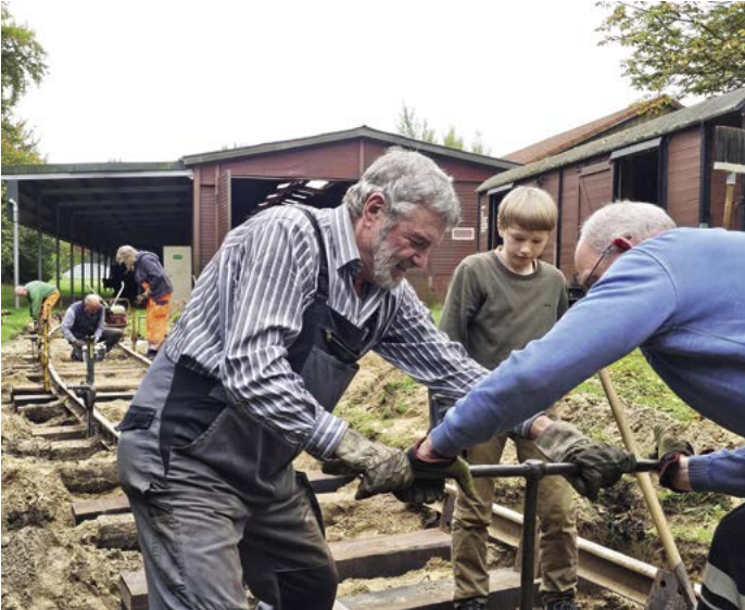
Am 11.10.25 werden in Heiligenberg die Gleise vor der Fahrzeughalle und ihre Sandbettung durchgearbeitet.
