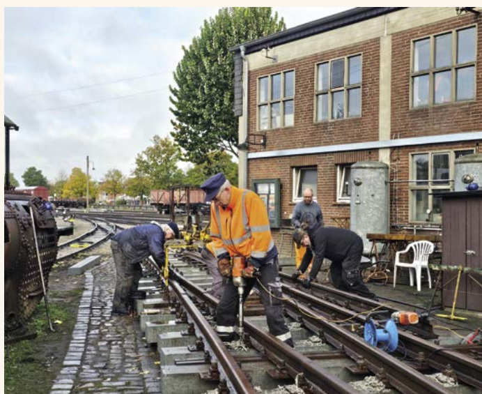
Alles wie gehabt: Der gleiche Ablauf wurde anschließend auch für die Weiche 7 durchgearbeitet.
