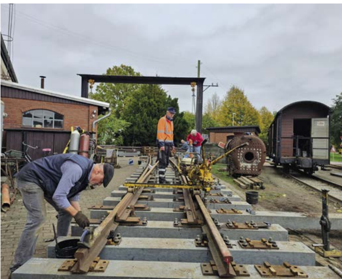
Montage der Weiche 3 vor der Werkstatt in Bruchhausen-Vilsen. Anschließend...
