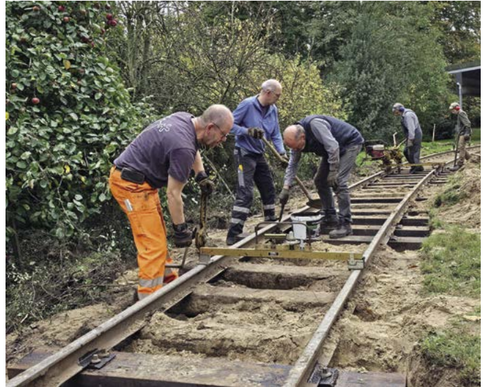
Für die Instandsetzung der Gleisanlagen ist trotz maschineller Unterstützung viel manuelle Arbeitskraft vonnöten.
