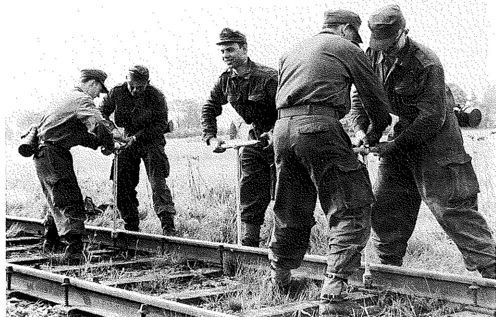
*Oben: Soldaten schrauben das Meterspurgleis auseinander. Dabei werden sie gegen „Luft- und Partisanenangriffe“ gut geschützt. Das Meterspurgleis liegt auf bereits vorgebohrten Regelspurschwellen.*
